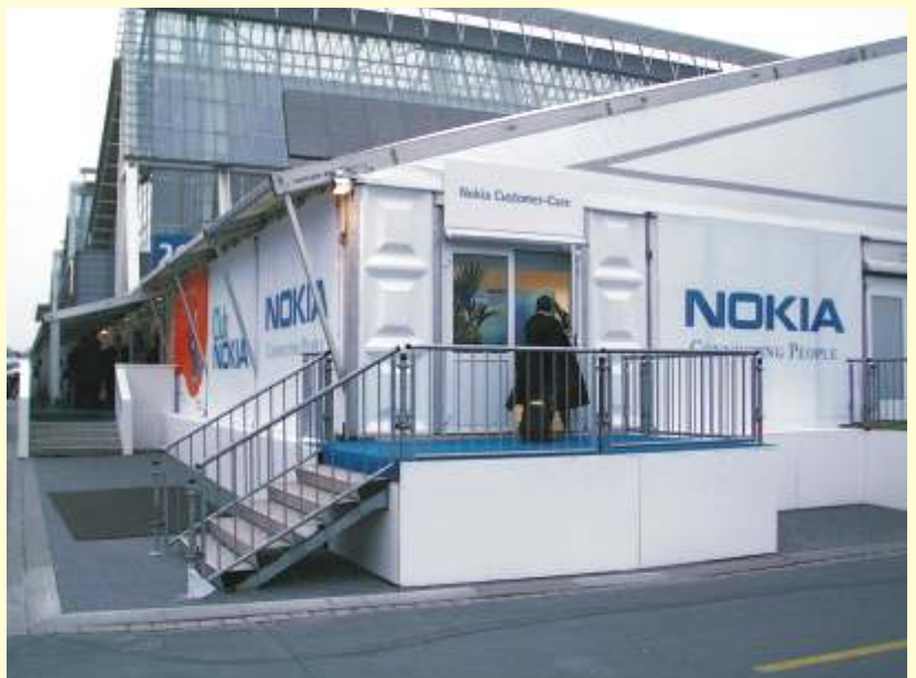
32 m freitragend, 1,20 m Unterbau
